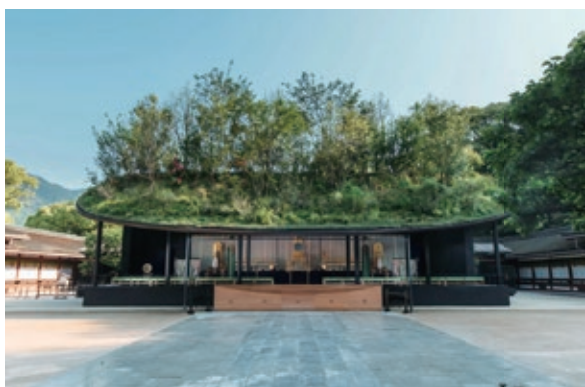
太宰府天満宮本殿の改修に伴い特別に建設された「仮殿」=同宮のホームページから
